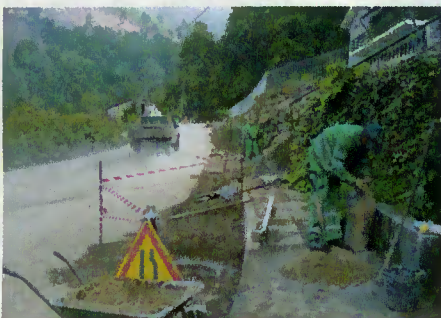
Trabalhadores da autarquia executam as obras
