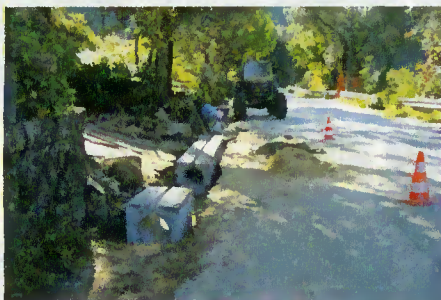
Obras para melhoria de acessos
