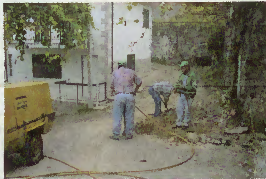
Execução da rede de água
