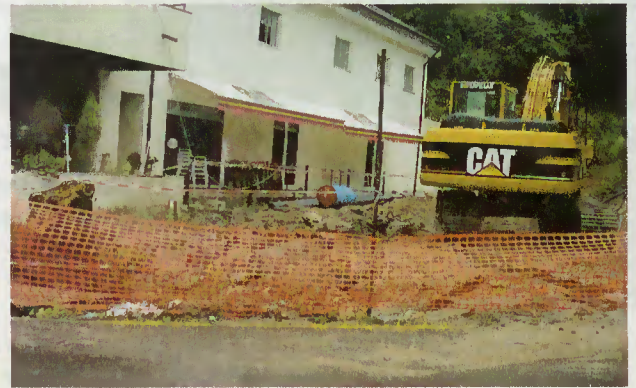
Intervenção na linha de água
