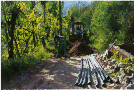
Abertura da rede de água em S. Pedro
