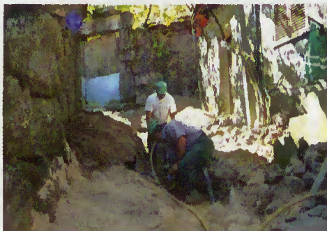
Intervenção em Frigueira
