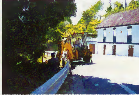
Abertura da rede de água próxima de Parada
