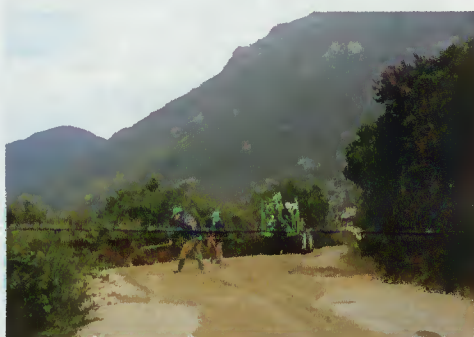
Manutenção da Estrada do Campo do Gerês à Portela do Homem
