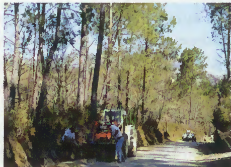
Limpeza da Estrada EN 307 Museu - Barragem
