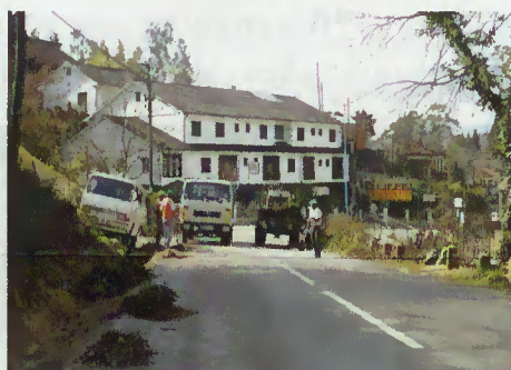
Limpeza da EN 308-1 Pontes de Rio Caldo - Gerês
