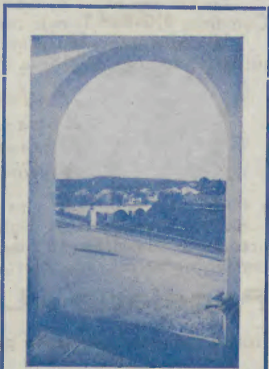
Um trecho da ponte sobre o Cávado.
