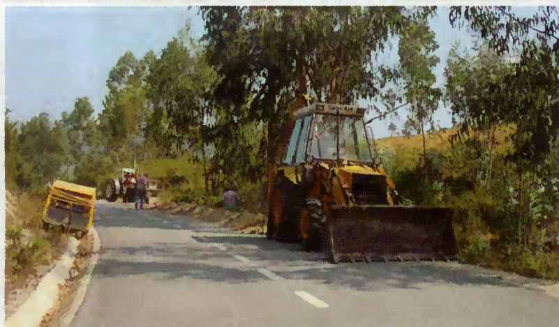
Ligação de furo de água ao reservatório de Cabaninhas e ligação de água deste ao reservatório da Mesquita-Gondoriz
