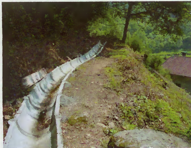
Construção e colocação de meias canas em levada - Pergoim - Chamoim
