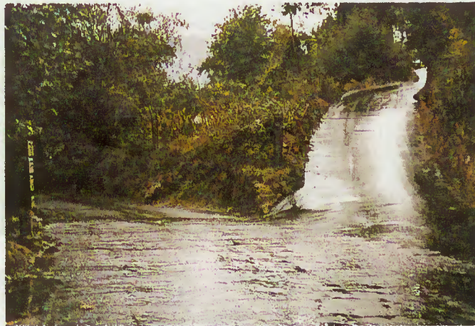
Estrada Municipal - Sr. dos Passos ao Lugar da Corujeira e entroncamento na Pedreirinha
