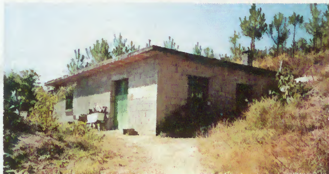
Projecto «Terra Nostra» - Antes da intervenção
