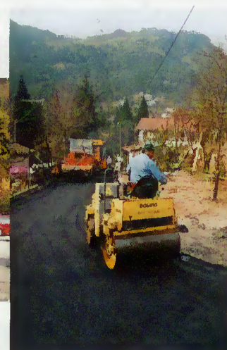
Pavimentação e arranjo de bermas - Águas de Assureira/E. N. 308-1
