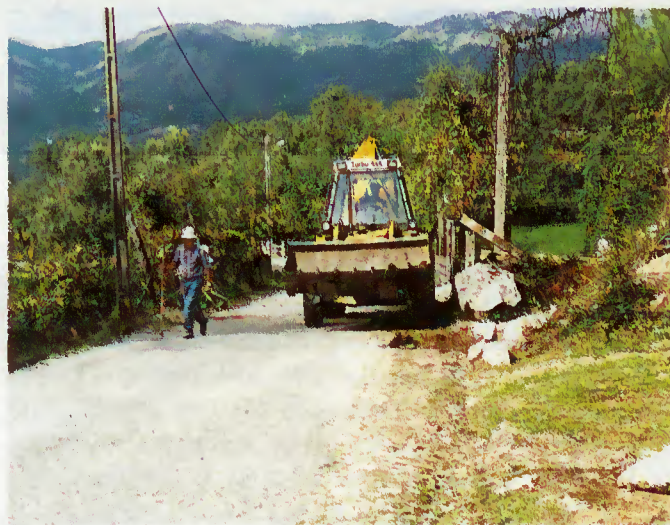
Repavimentação da E.N. 535 - Limpeza de bermas e valetas
