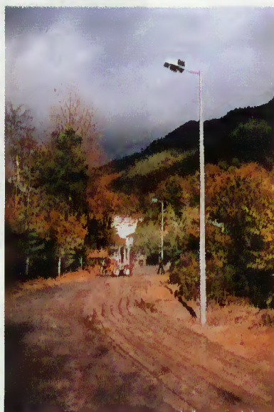
Iluminação da estrada - "Novo Sol"/Chã da Ermida - Gerês
