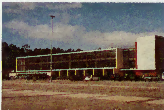
Edifício da Escola Profissional Amar Terra Verde
