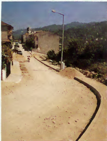
Intervenção na zona da Corredoura
