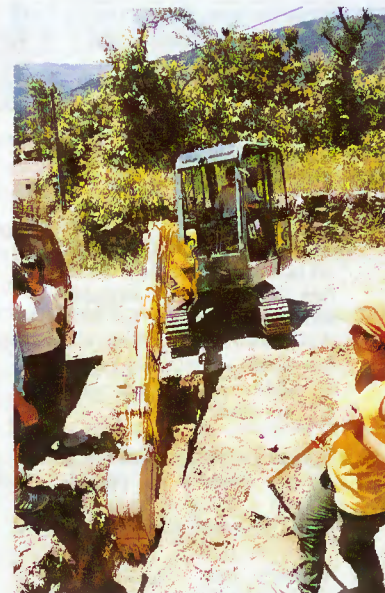
Execução de ramais domiciliários em Vilar da Veiga
