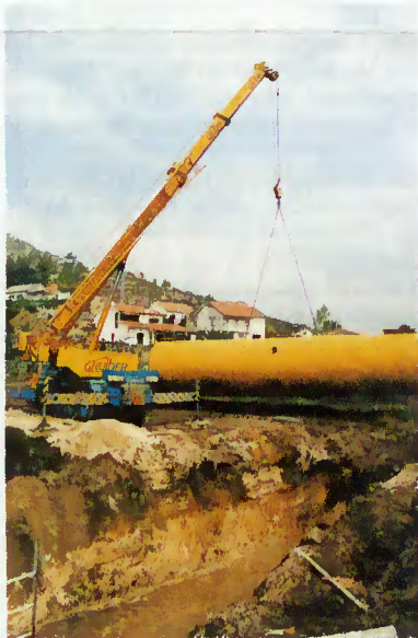
Construção de uma Etar
