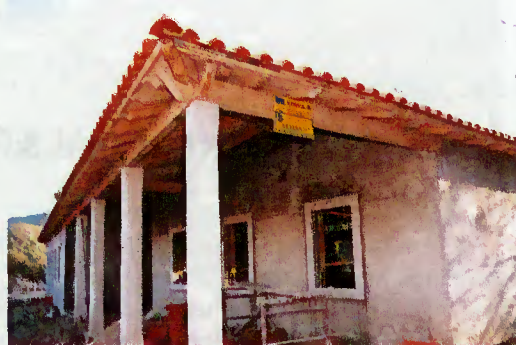
Recuperação de um edifício
