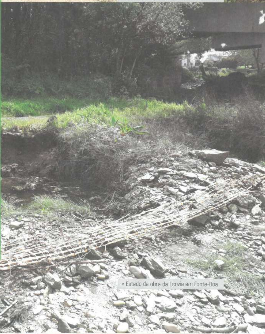
» Estado da obra da Ecovia em Fonte-Boa
