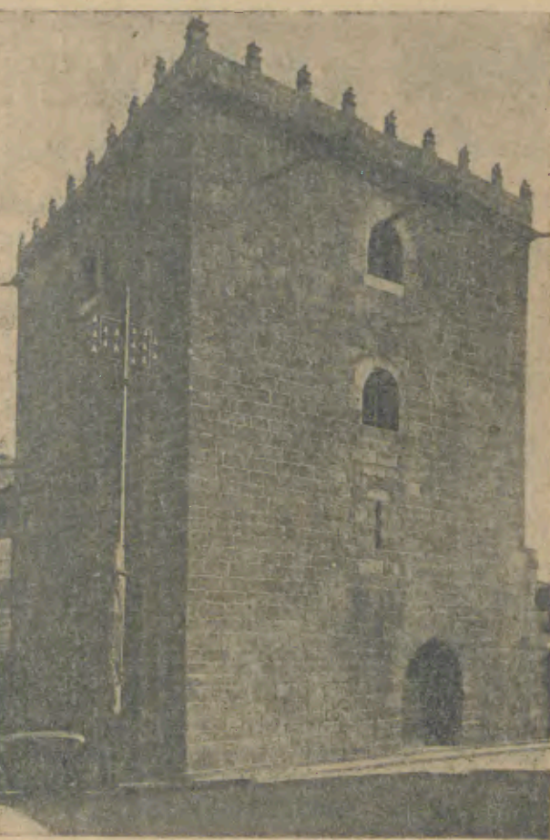
BARCELOS — A Torre de Menagem
