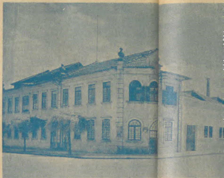
Edifício Saca Barcelense
