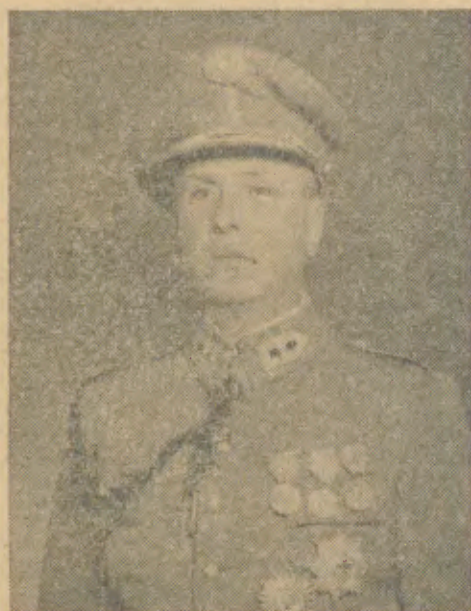
A fim de inspecionar as obras do novo Matadouro de Ponta Delgada, seguiu para aquela cidade este nosso ilustre Conterrâneo e respeitável Amigo.
