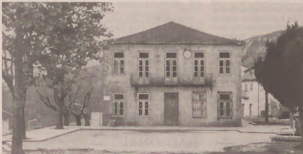
Paços do Concelho de Terras de Bouro, que agora vão sofrer obras de beneficiação
