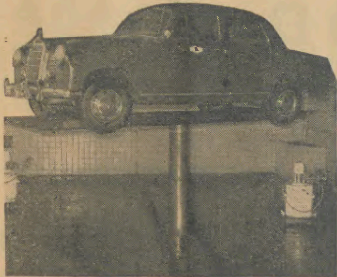
Estação de Serviço da Garagem Castro Largo do Teatro
