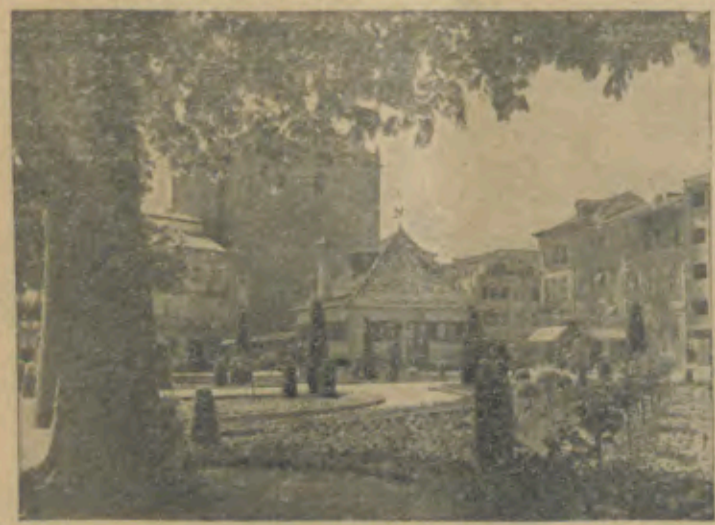
O Quiosque, ao qual se refere o nosso distintíssimo Colaborador neste brilhante Artigo e que actualmente se encontra em péssimo estado de conservação.
