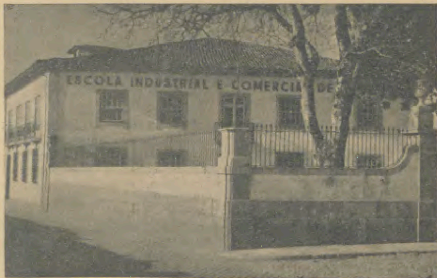
A antiga Casa dos Mendanhas, onde, hoje, junctona a Escola Industrial e Comercial de Barcelos
