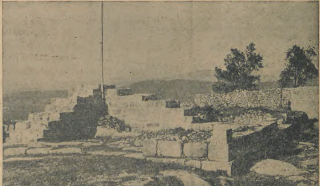
Como se encontra, hoje, o recinto onde estão os alicerces da Torre de Menagem do Castelo de Faria. Aqui deram-se grandes combates entre portugueses e Espanhoes
