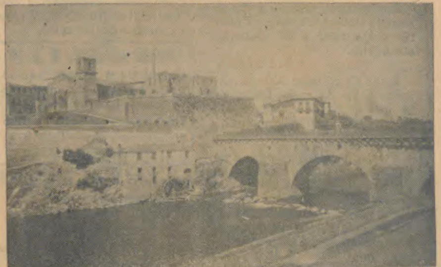
O Rio Cávado, onde se vai realizar o Arraial na noite de 4 de Maio
