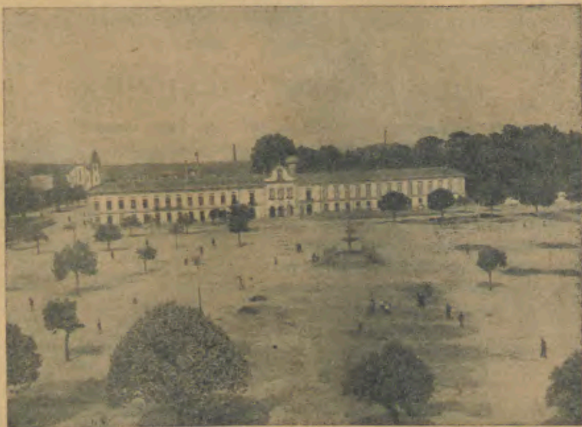
BARCELOS—O magestoso Edifício do Hospital, em beneficio do qual se vai realizar um Cortejo de Oferendas
