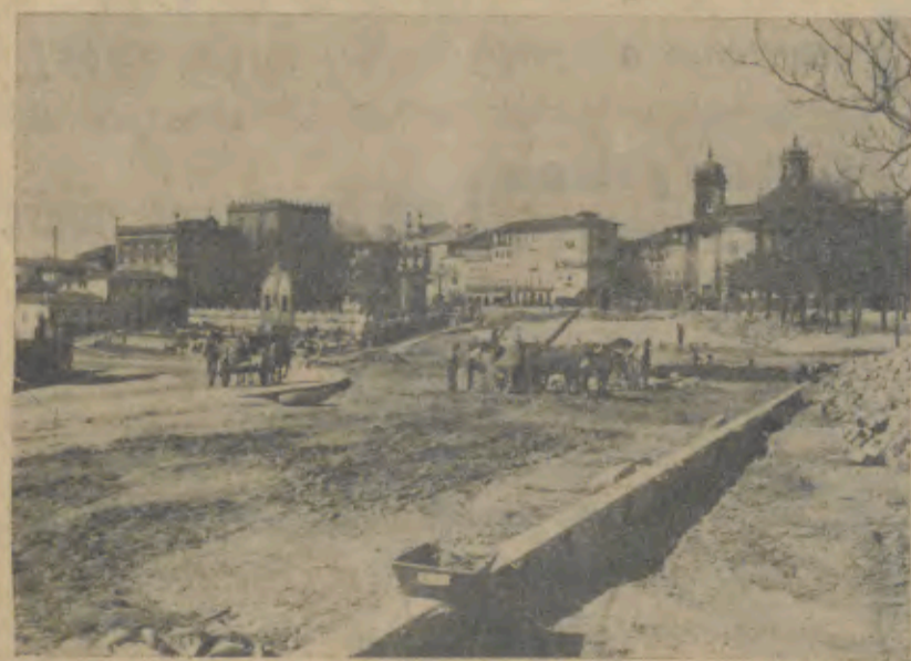
Grande pavimentação na Avenida Dr. Sidónio Pais
