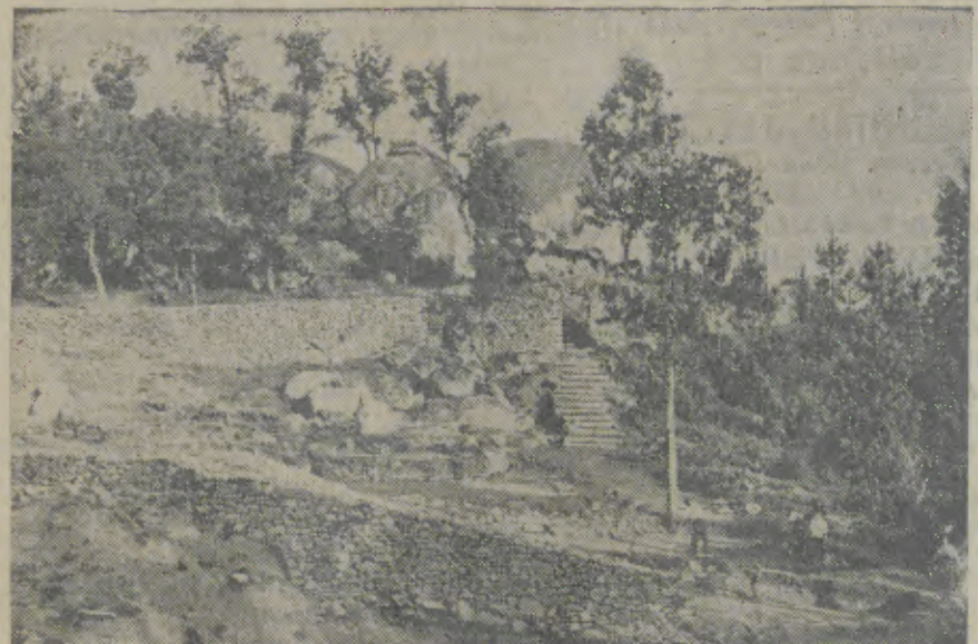
Subida para as Ruínas da Torre de Menagem do Castelo
