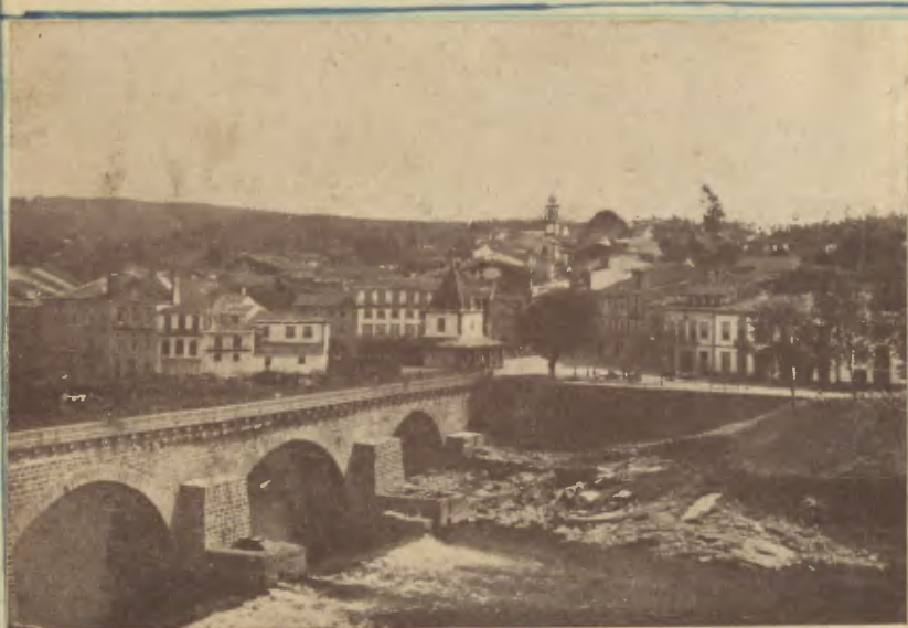
Vista geral de Barcelinhos
