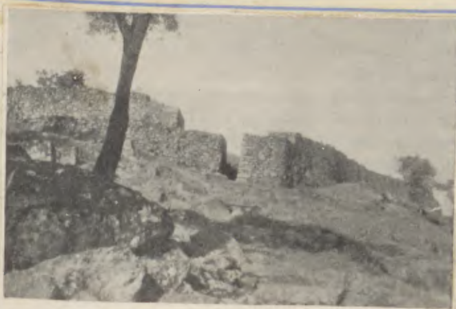
FRANQUEIRA — MURALHAS DO CASTELO DE FARIA (LADO NASCENTE)
