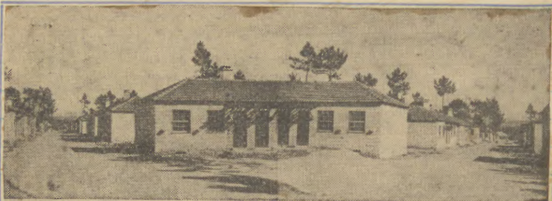
O bairro operário de Barcelos, constituído por uma centena de moradias acolhedoras, está situado num dos pontos mais centrais da cidade.
