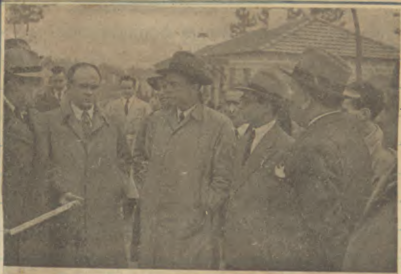
O Sr. Eng. José Frederico Ulrich, dig. mo Ministro das Obras Públicas, acompanhado do Chefe do Distrito e do Dr. Mário Norton, visitando as obras do novo Bairro Económico de Barcelos
