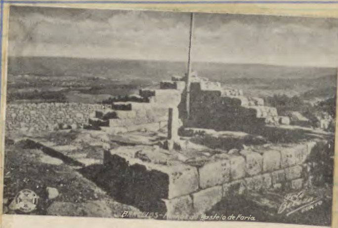
FRANQUEIRA - RUINAS DO CASTELO DE FARIA
