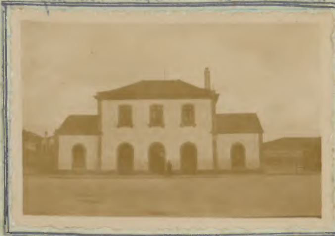
Edifício da 1.ª Estação dos Cam. de Ferro em Barcelos
