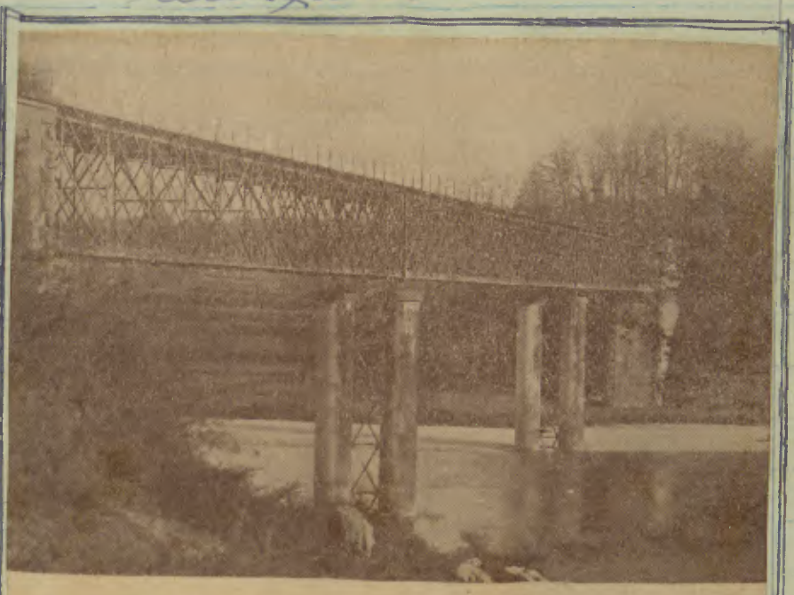
BARCELOS — Ponte do caminho de ferro, sobre o Cávado
