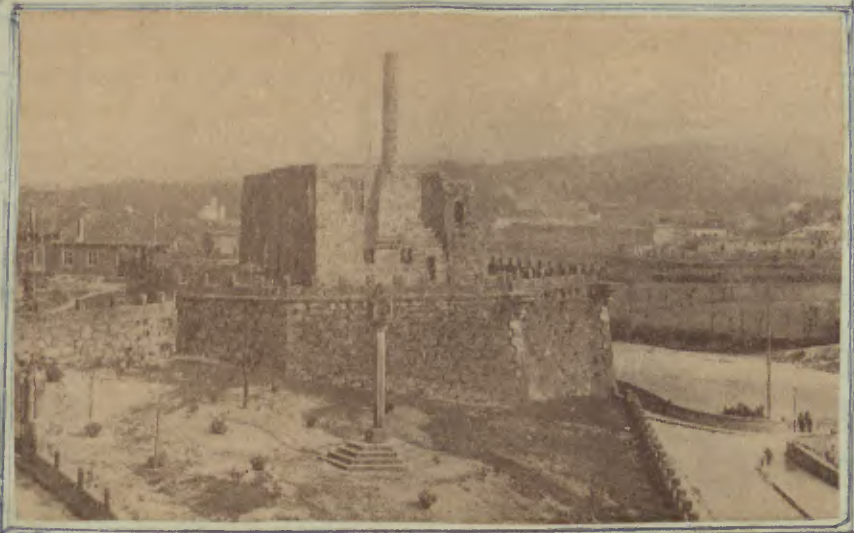
Palácio dos Condes em que ainda está instalado o Museu Pedagógico, visto de Rua Condes de Bragança.
