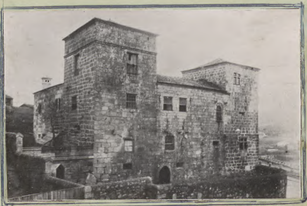
"Solar dos Pinheiros" - Face voltada para a Rua dos Paços de Bragança.
