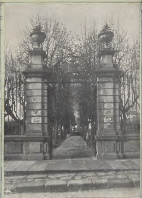
Entrada da Praça D. Pedro V pelo lado da Rua D. Joana de Freitas. Ve-se o passeio antigo.
