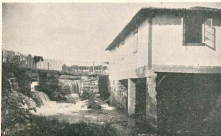
2 — Aspecto da palafita sobre o afluente do Cávado
