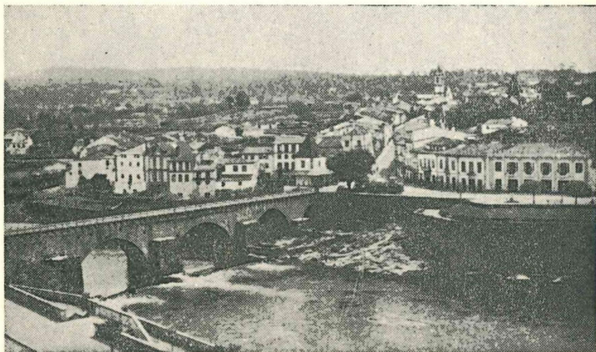
VISTA GERAL DE BARCELINHOS
