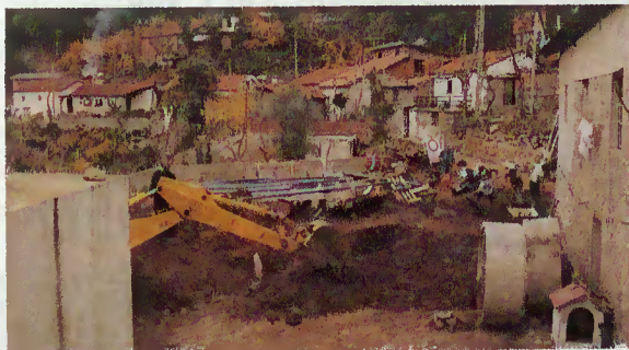
Obras de saneamento no lugar de Assento, Valdozende
