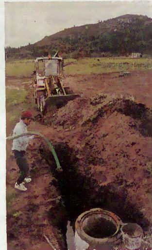
Obras de saneamento em S. João do Campo
