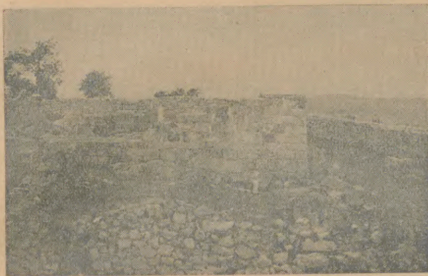
Ruínas da Torre de Menagem do Castelo de Faria, postas a descoberto pelo Grupo Alcaides de Faria
