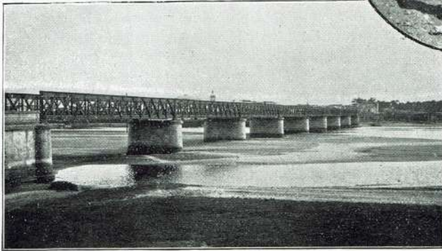
PONTE DE FÃO E ESPOZENDE
