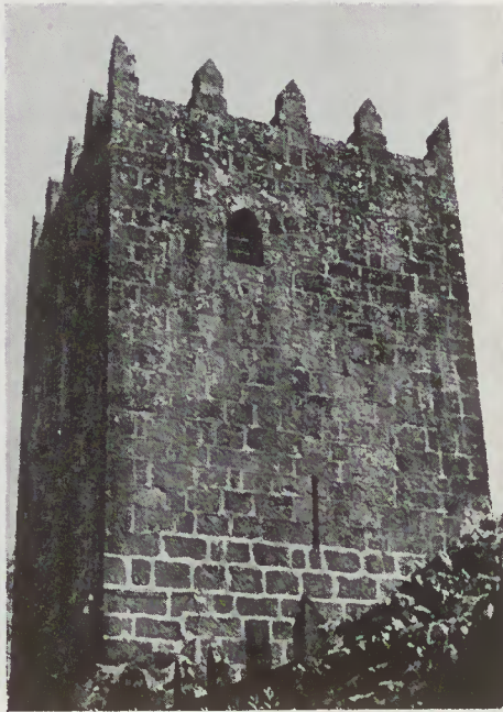
Fig. 22 — Penagate: Aspecto da torre, fachada norte e nascente.
