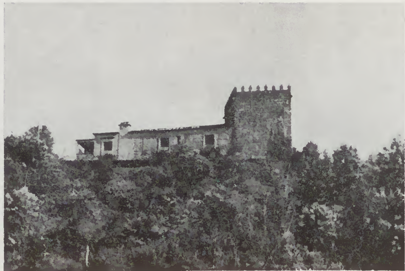
Fig. 33 — Geraz: Aspecto da torre e solar.
