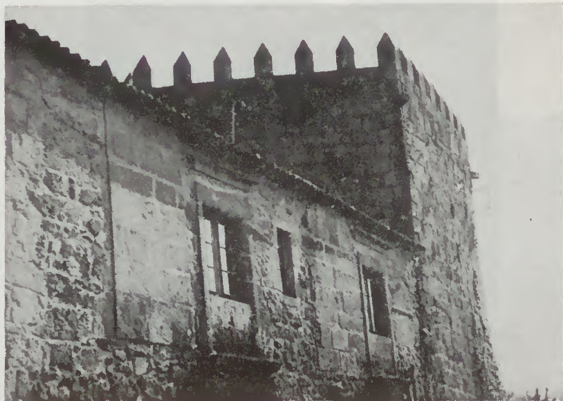
Fig. 34 — Geraz: Outro aspecto da torre. Notar as gárgulas em forma de caleiro e a parede norte que não é perpendicular às outras.
