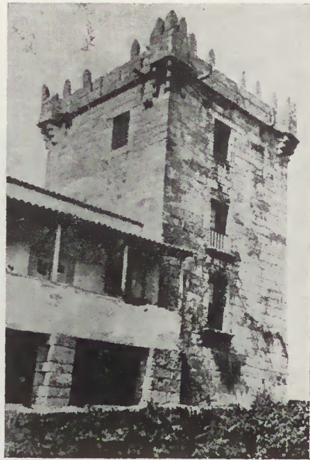
Fig. 18 — Crasto: Aspecto da torre em 1906.
