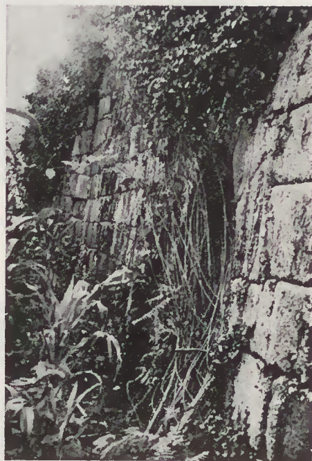
Fig. 5 — Vasconcelos: Porta de acesso ao solar.
