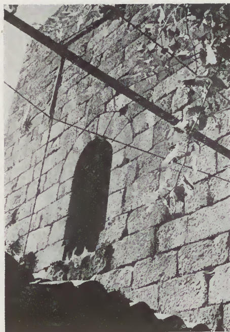
Fig. 13—Dornelas: Porta de acesso em nível superior ao solo. Notar a soleira quebrada.
