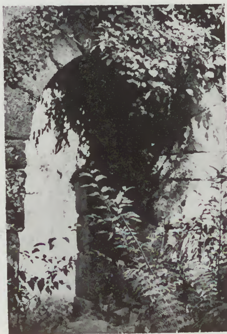
Figura 9—Vasconcelos: Porta da entrada da torre, vista do interior.
