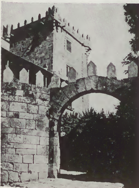
Fig. 20 — Crasto: Aspecto actual da torre.
