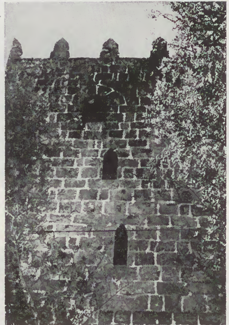
Fig. 23 — Penagate: Outro aspecto da torre, fachada sul.
