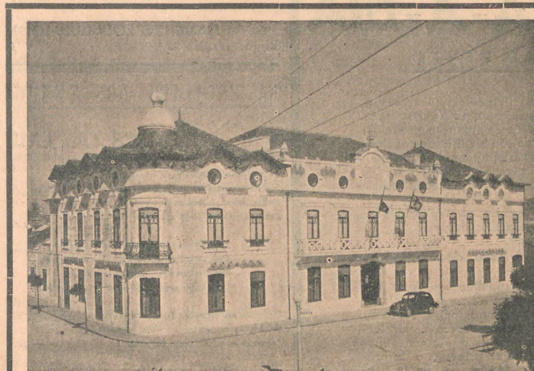
Fachada principal do Colégio — voltada para o Jardim da Av. Júlio Graça.
