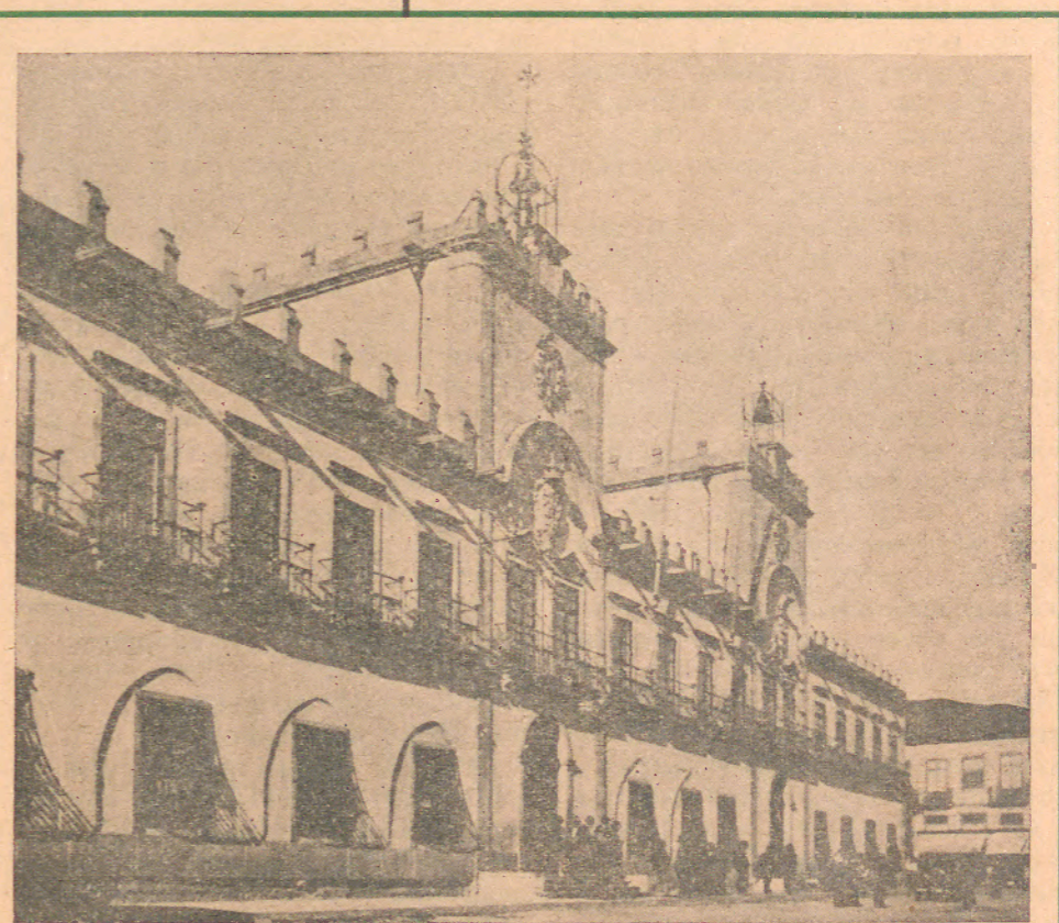
BARCELOS — Edifício da Câmara Municipal e Paços do Concelho
