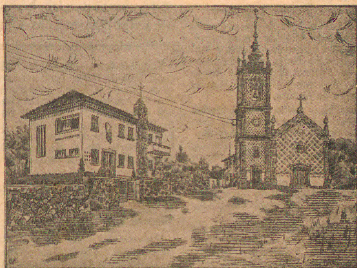
Igreja e residência paroquial de Cristelo
