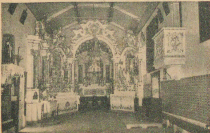
Capela-mor da Igreja de Gilmonde, completamente restaurada, vendo-se também uma porta do corpo da igreja.
