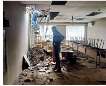
Edifício de Associação Humanitária em Yrpin
