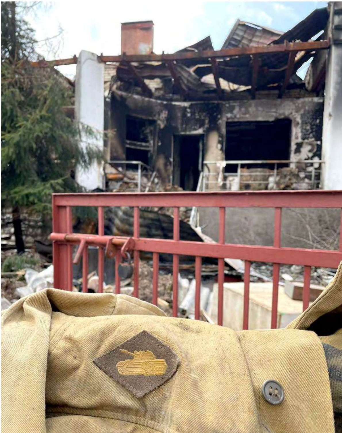
Edifício de Associação Humanitária em Yrpin
