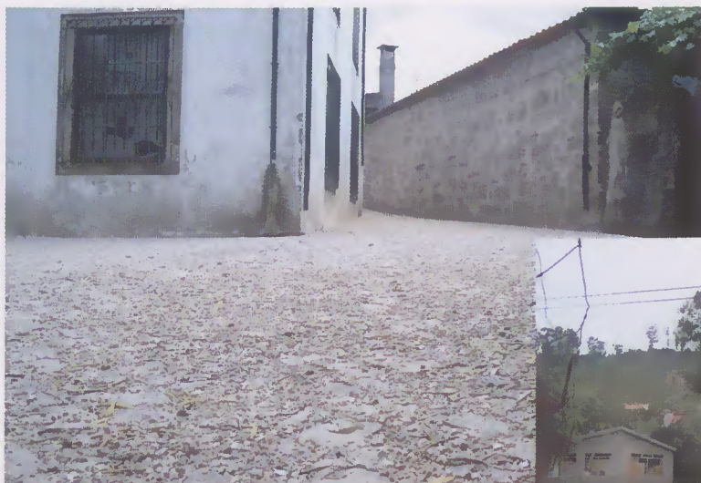
Amares (repavimentação das traseiras dos antigos Paços do Concelho)
