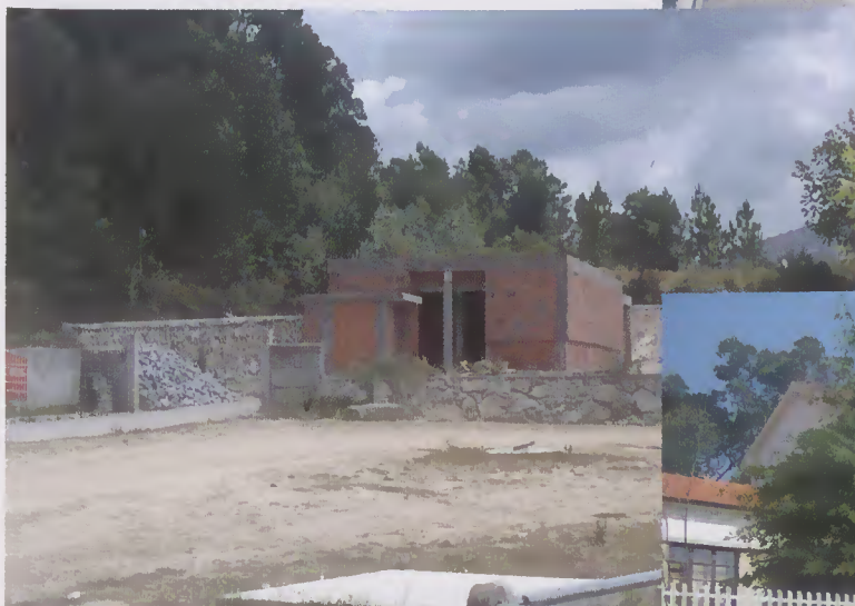
Amares (construção do balneario da piscina)
