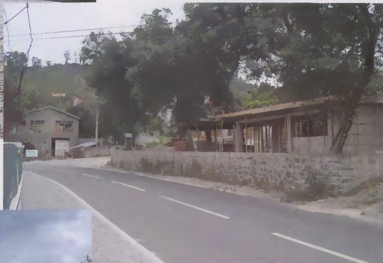
Besteiros (construção de edifício de apoio no Largo do Areal)
