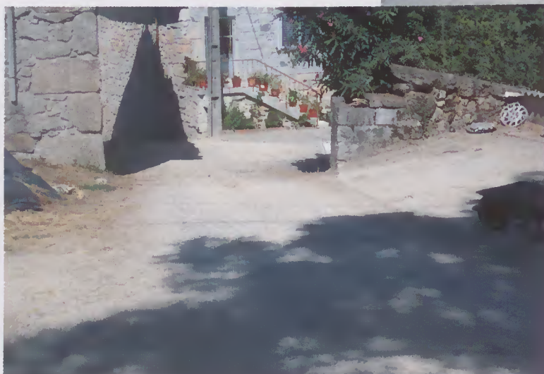
Paredes Secas (pavimentação de caminho junto à Igreja)
