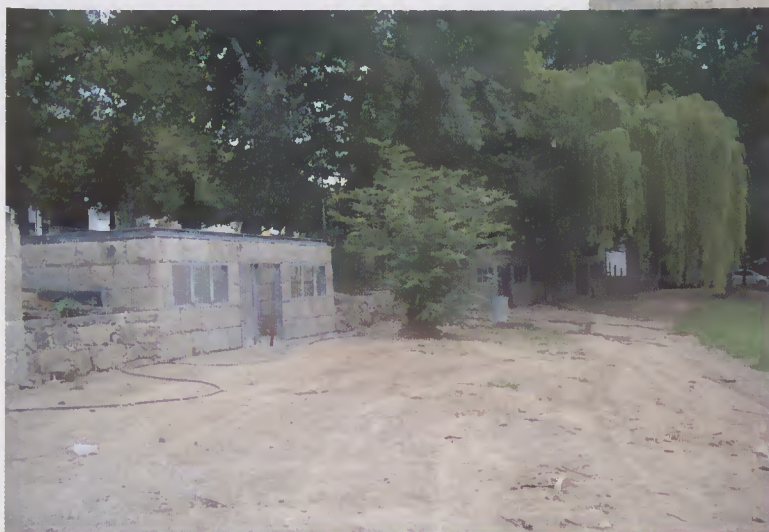
Caldelas (Construção de Posto Turismo - Parque das Termas)
