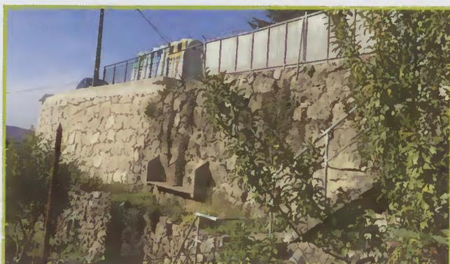
Reconstrução de muro com fundação em betão, repavimentação da estrada e sistema de drenagem de águas residuais na Rua Nossa Senhora da Abadia, Bouro Sta. Maria. Câmara Municipal
