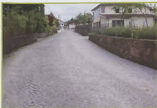
Pavimentação da Rua da Ribeira (Lago) Município de Amares em parceria com a Junta de Freguesia
