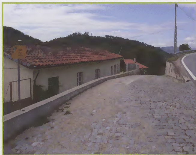
Pavimentação da Rua dos Rios (Caires) Município de Amares em parceria com a Junta de Freguesia
