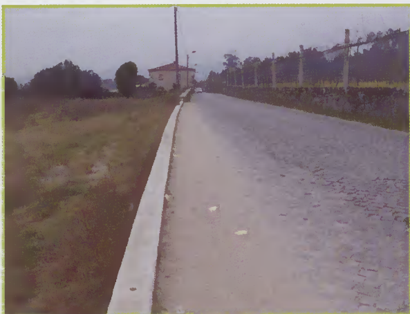
Construção de muro para alargamento da Rua do Mosteiro ( Rendufe )
