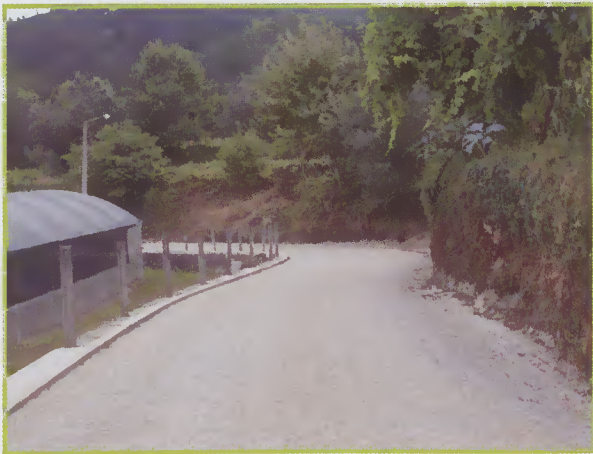
Saneamento na Avenida Manuel Jesus Afonso ( Caldelas )
