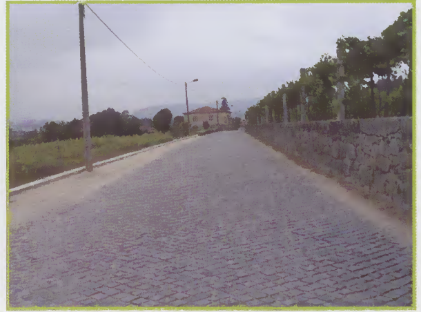
Construção de muro Avenida da Cova ( Rendufe )
