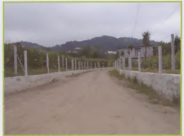
Alargamento da Rua da Breia ( Dornelas ) CMA e Junta de Freguesia
