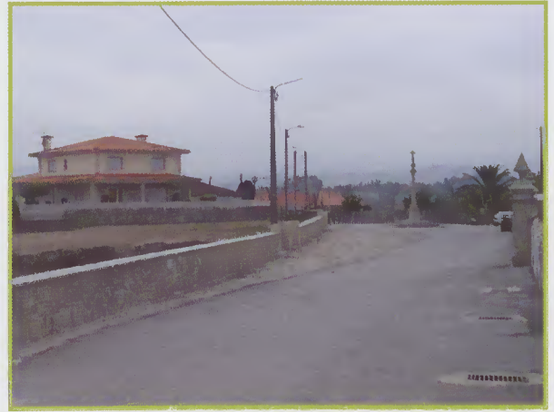
Alargamento da Rua da Igreja ( Fiscal )
