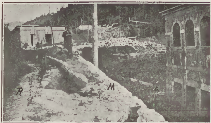
FIG. 5 — VUE DE LA VALLÉE DE L'ALBITO, MONTRANT LE NOUVEAU LIT DU RUISSEAU R ET L'ANCIEN LIT, DÉBLAYÉ EN PARTIE, POUR FAIRE LES CAPTAGES SUR LESQUELLES A ÉTÉ BÂTI L'ÉTABLISSEMENT THERMAL A, M — MUR DE SOUTÈNEMENT
