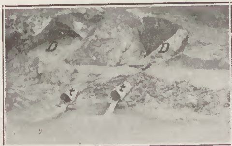
FIG. 10 — D D — DIACLASES TRANSVERSALES tt — TUBAGE EN GRÈS AMENANT L'EAU CAPTÉE DANS LES DIACLASES TRANSVERSALES VERS LE RÉSERVOIR DES CAPTAGE DE SOURCES N. OS 7 À 10
