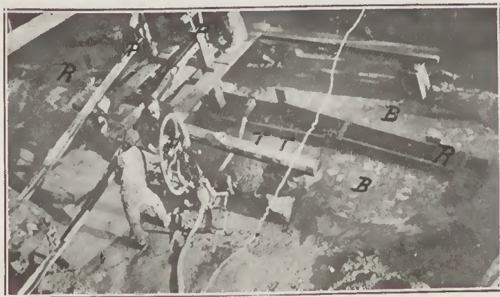
FIG. 11 — CONSTRUCTION DU RÉSERVOIR SUR LES SOURCES N. OS 7 À 10 P P P — TROIS POMPES D'ÉPUISEMENT. — R R — RÉSERVOIR SUR LE FILON THERMAL ON VOIT LA CAGE EN PLANCHES QUI A ÉTÉ DISPOSÉE SUR LE FILON, TANDIS QUE L'ON BATAIT-LE BÉTON. — B B — CETTE CAGE A ÉTÉ ENSUITE ENLEVÉE. — T T — TUBES EN GRÈS AMENANT L'EAU DES DIA- CLASES TRANSVERSALES.
