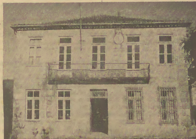
Edifício da Câmara Municipal de Terras de Bouro
